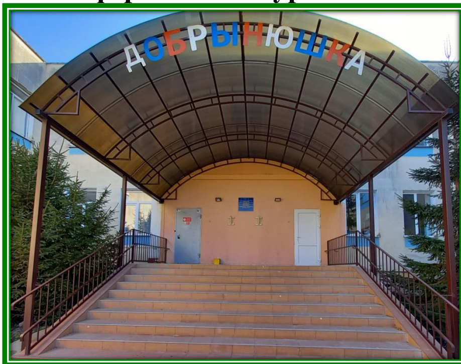
На снимке: здание МБДОУ № 97 «Добрынюшка» г. Симферополь
